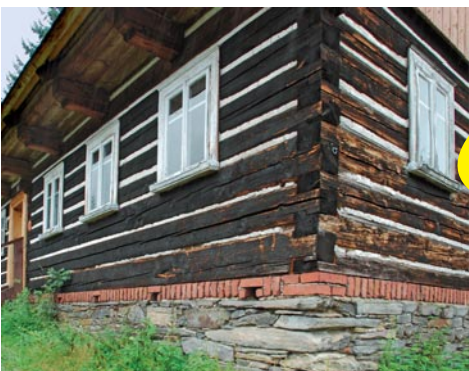
Oprava spodní stavby
